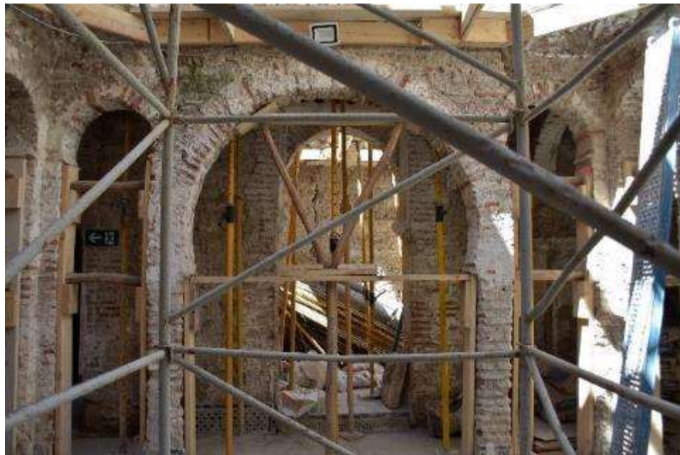
Figura 3. Trabajos de escaneado en Dar Bem Marzouk
