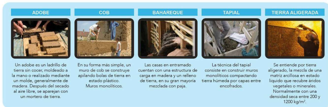
Figura 2. Técnicas constructivas con tierra
