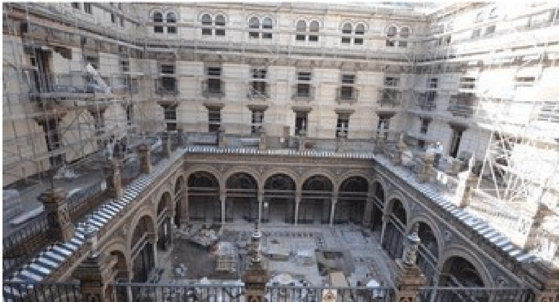
Figura 12. Patio de San Fernando, en las obras realizadas en 2011.
